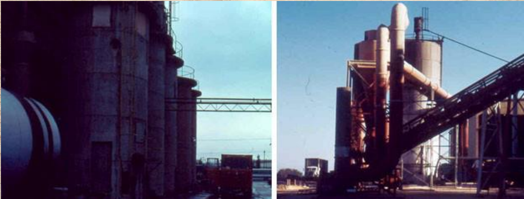
Αποθηκευτικοί χώροι (σιλό) υγρών και ξηρών ξυλοτεμαχιδίων
