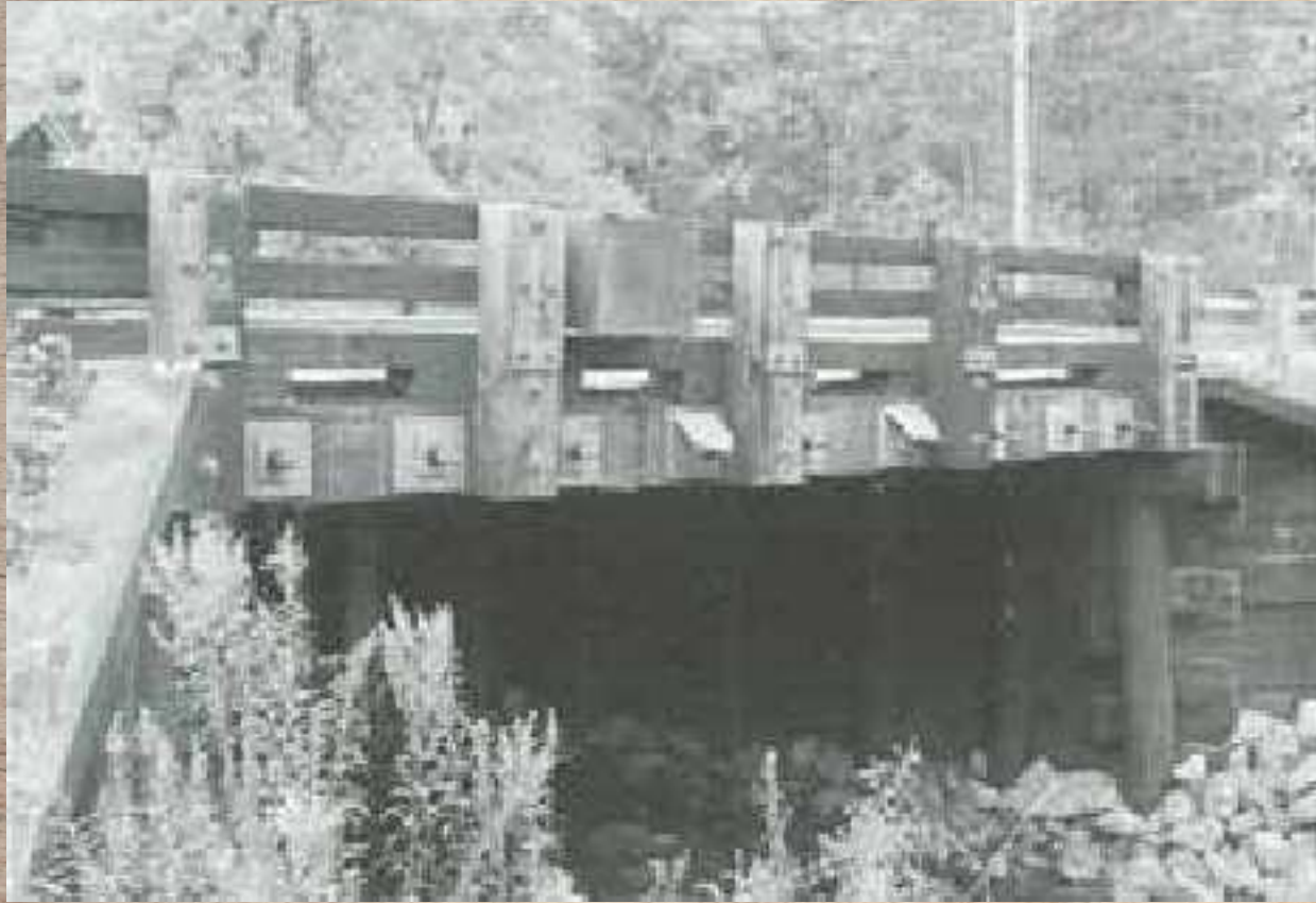
Γέφυρα κατασκευασμένη με ξύλινα μέρη εμποτισμένα με πισσέλαιο
