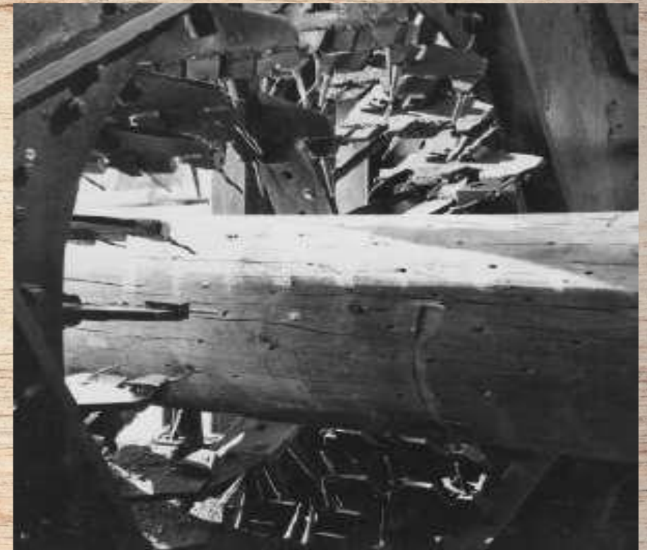
Διάνοιξη εσοχών // με τις ίνες του ξύλου
