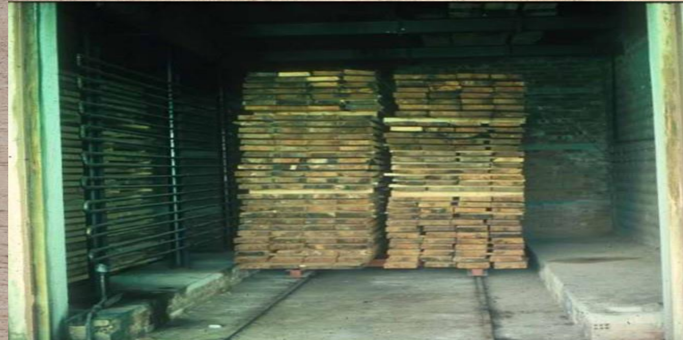
Εσωτερικό θαλάμου ξηραντηρίου ενιαίας ξήρανσης
