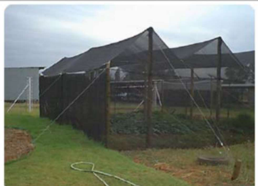
Διχτυοκήπιο σκίασης ξύλινου στηρικτικού σκελετού δίρριχτης οροφής
