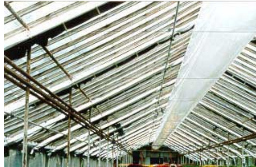
Πλαστικός σωλήνας διανομής θερμού αέρα. Οι οπές είναι πλάγια κάτω
