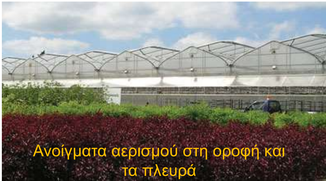
Ανοίγματα αερισμού στη οροφή
