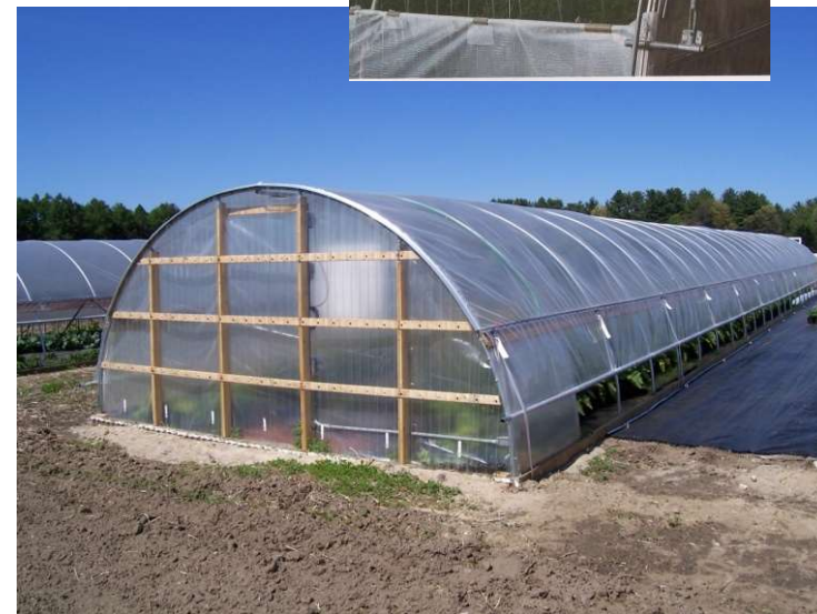
Ανοίγματα αερισμού στα πλευρά
