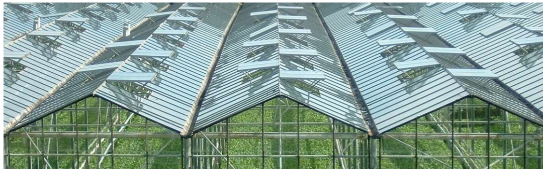
Ανοίγματα αερισμού στη οροφή
